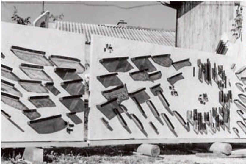
Réalisation des dalles verre-béton à Champlevert
